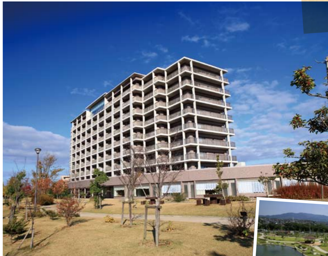
建物所有 / (株) キューデン・グッドライフ東福岡 土地所有 / (株) キューヘン
